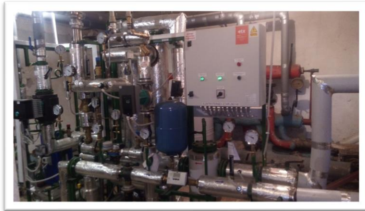
Sienkiewicza 2/13 (w trakcie modernizacji)
