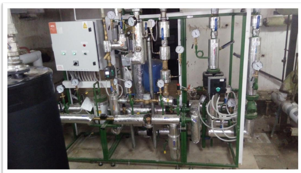
Bagno 2 (w trakcie modernizacji)
